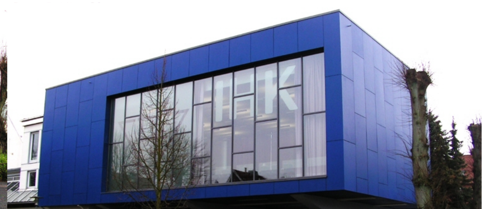
Saal nach Umbau (Straßenseite)
